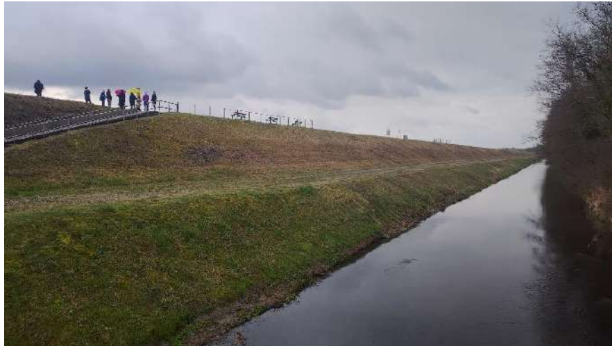
Abbildung26 : Bestehende Rampe und Treppe
