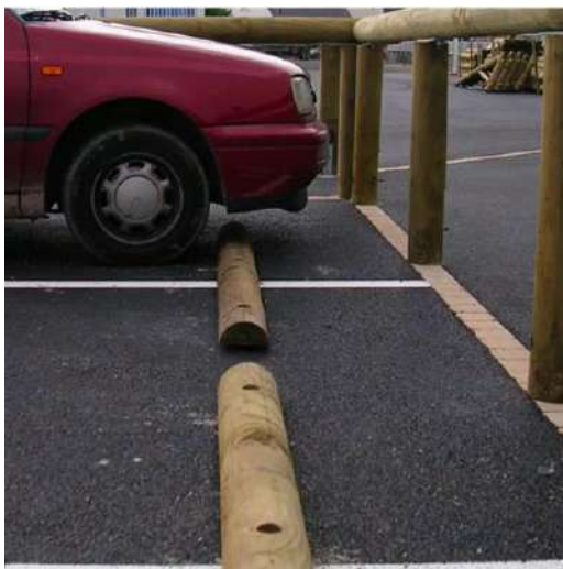
Abbildung23 : Beispiel für Stopper und Holzbarriere auf einem Parkplatz
