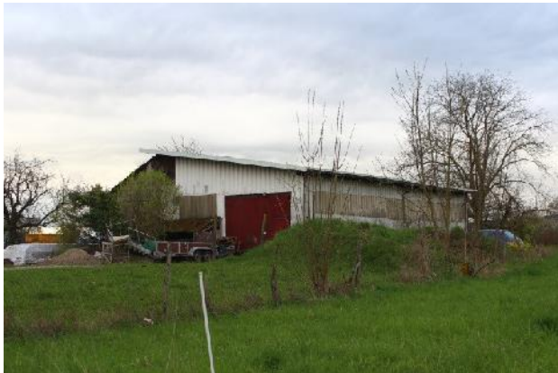
Abbildung 8: Große Scheune im Plangebiet
