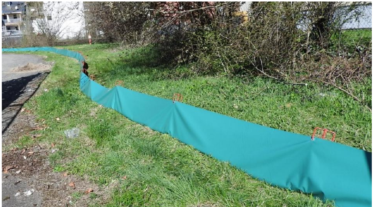
Abbildung 26: Mobiler Zaun zur Vermeidung des Einwanderns bodengebundener Kleintiere (z.B. Eidechsen) in das Baufeld
