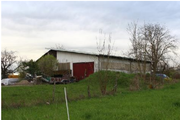
Abbildung 8: Große Scheune im Plangebiet
